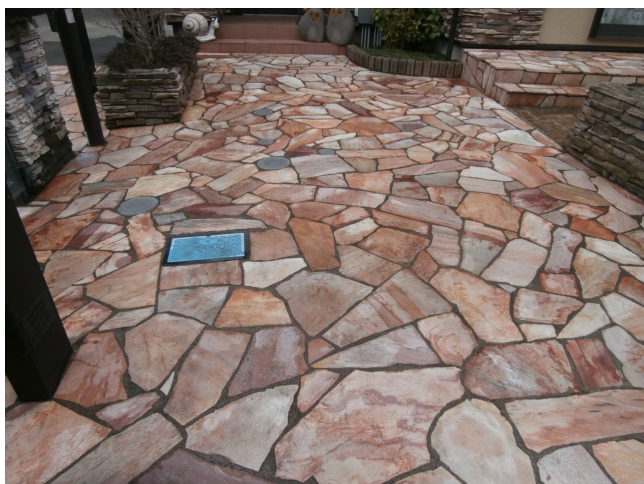
2 回目の塗装完了
