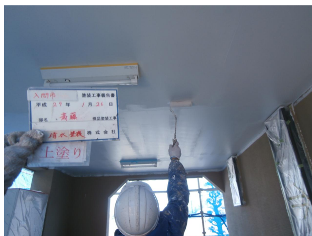
天井2回目上塗り
