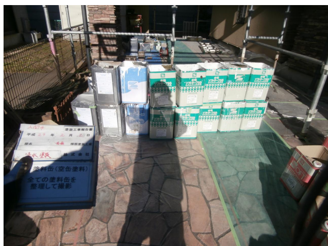
使用後下塗り 壁
