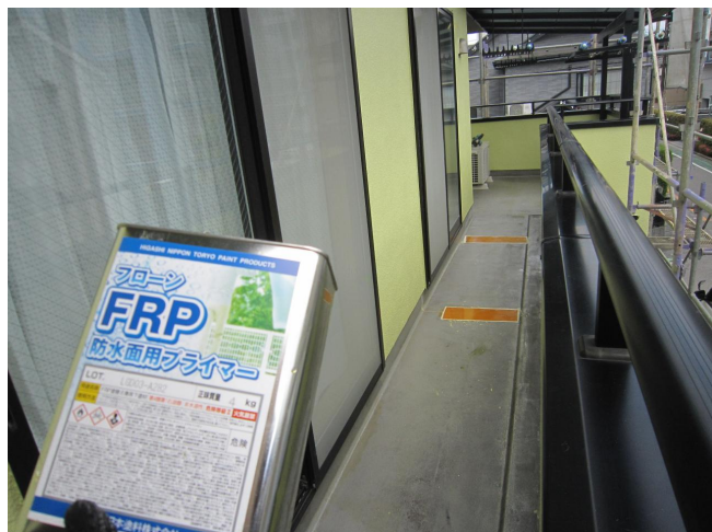
ベランダ床全体到下塗り
