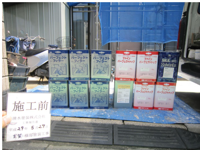
壁材料工事前
